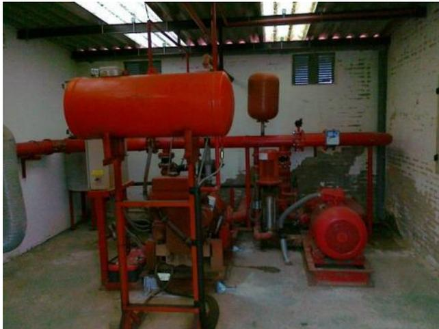
El Hospital de Sagunto dispone de un ABASTECIMIENTO DE AGUA formado por ALJIBE y GRUPO DE PRESIÓN de uso exclusivo, capaz de alimentar con caudal y presión suficientes a todas las instalaciones que deban funcionar simultáneamente durante el tiempo de autonomía requerido.
